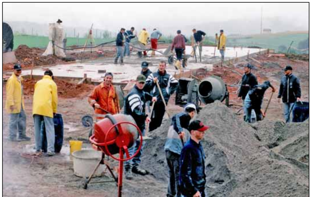
Bild 31: Betonieren der Bodenplatte Kabinentrakte
